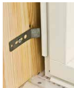
Gilje Monteringsbeslag for vindu uten utforing og Gilje Monteringsbrikke.
